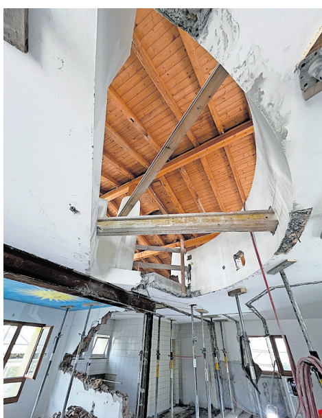
Die Bauarbeiten schreiten voran: Blick in den Dachstuhl.
