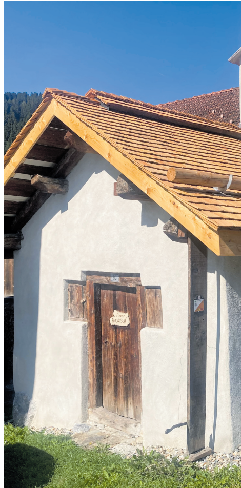
Der instand gesetzte Holzbackofen.
