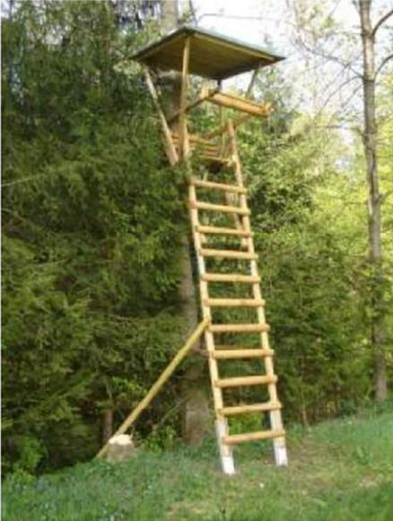
Einfache Jagdeinrichtung aus Holz (Ansitzleiter), Befestigung mit Zurrgurten am Baum, leicht und flexibel
